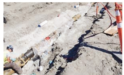
Anodes sacrificielles Bren-Technologies utilisées conjointement avec les produits de pétrolatum PCS.
